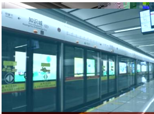
站台屏蔽门系统 (PSD)
